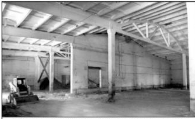
Ведется реконструкция новых производственных цехов.
