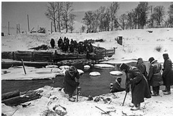
Фото 2. Сапёры возводят разрушенный мост. Наро-Фоминск, декабрь 1941 года
